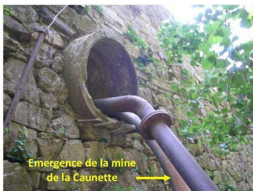
Photo 1 : Tuyau d'émergence de la mine de la Caunette
