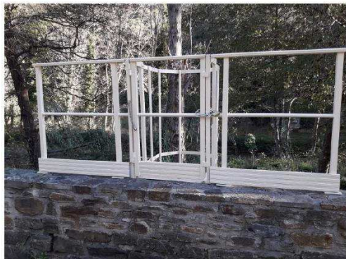
Photo 3 : Accès sécurisé depuis la route (23/12/20)
